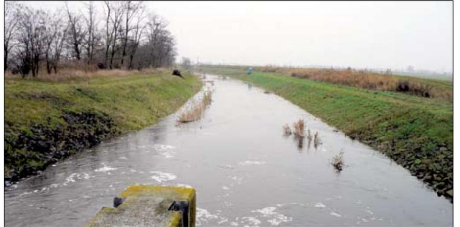
**Beide Schleusenkammern wurden für drei Tage geöffnet, um die Funktionsfähigkeit des gesamten Ableitungssystems zu testen.**
