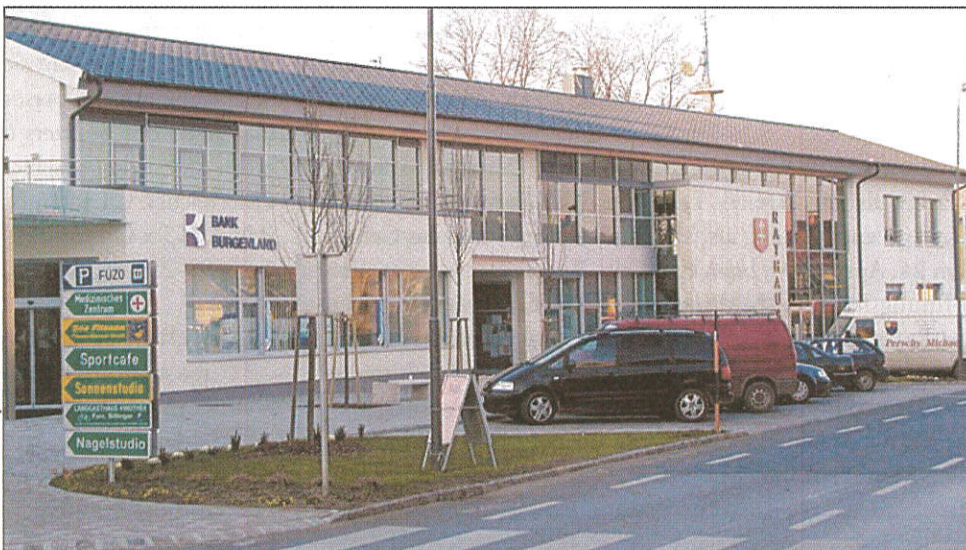
Nach 16 Monaten Bauzeit schon voll in Betrieb: das multifunktionale neue Rathaus in der „kleinen Stadt am Land“, wie sich Frauenkirchen auch nennt.
