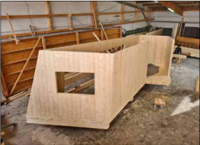
Ohne Dach und Fassadenverkleidung kann man die Einfachheit und Funktionalität des neu entworfenen Hides gut erkennen.
