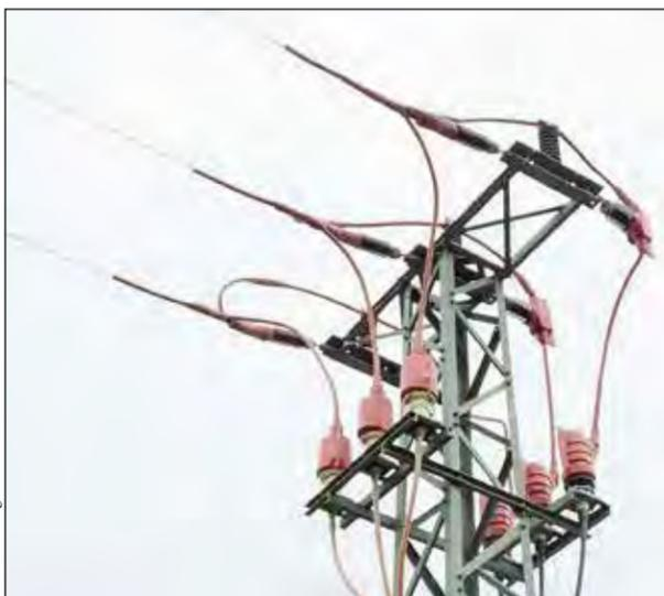
Ausreichend große Isolatoren sollen die Verletzungsgefahr durch stromführende Teile verringern.
