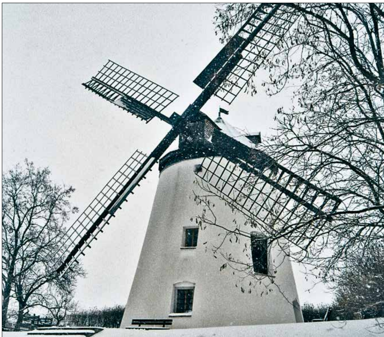
Auf den ersten Blick sieht die letzte burgenländische Windmühle gut erhalten aus, die Probleme stecken aber im Detail: Von der Mauertrockenlegung über die Lagerung des Rollenkranzes bis zum Tausch von Holzteilen gibt es viel zu tun.
