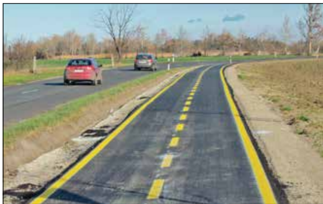
Wie hier im Bereich des Esterházy-Schlusses wurden mehrere Abschnitte der Radbegleitwege komfortabel ausgebaut.
