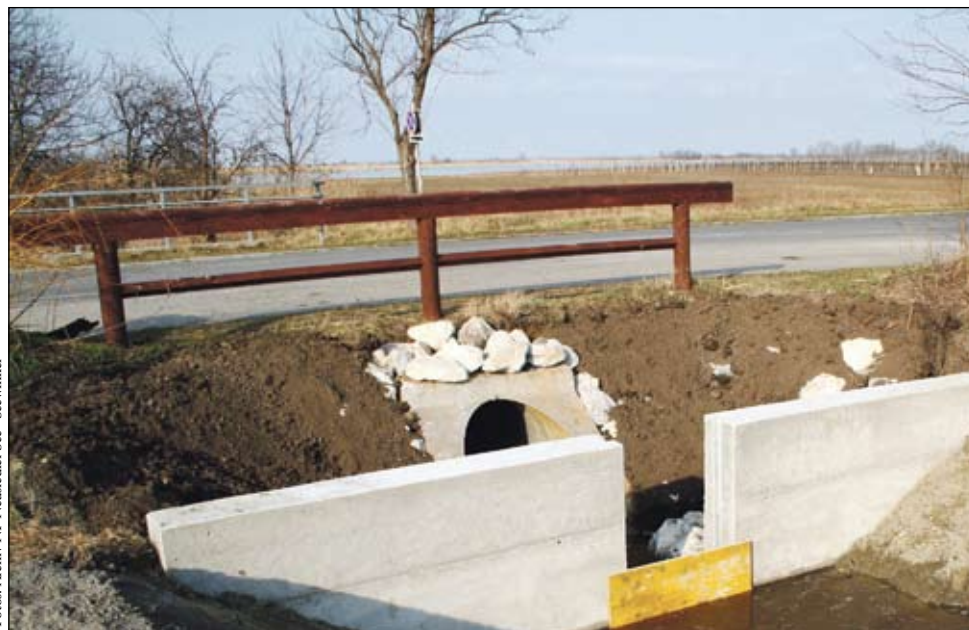
Erst im Vorjahr wurde eine Reihe von Einbauten in Entwässerungsgräben in der Bewahrungszone Illmitz-Hölle vorgenommen – mit Erfolg für Lacken und Grundwasser.
