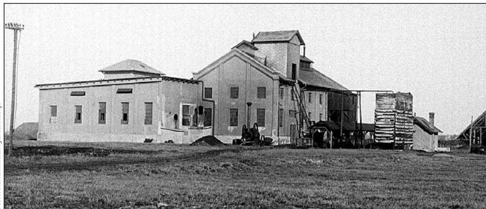
Von den 1925 errichteten Gebäuden sind heute nur mehr Mauerreste und Fundamente zu finden. Schon am Ende des Zweiten Weltkrieges wurde die Stromproduktion eingestellt.
