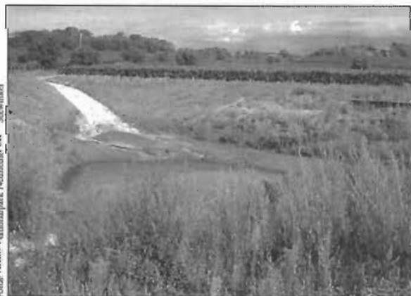
Insgesamt 6.000 Kubikmeter beträgt das Volumen des neuen Rückhaltebeckens bei Weiden am See.
